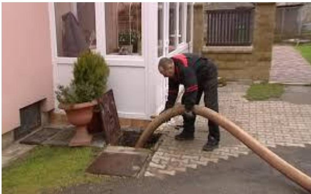
Obrázek 1- Odčerpání odpadní jímky
